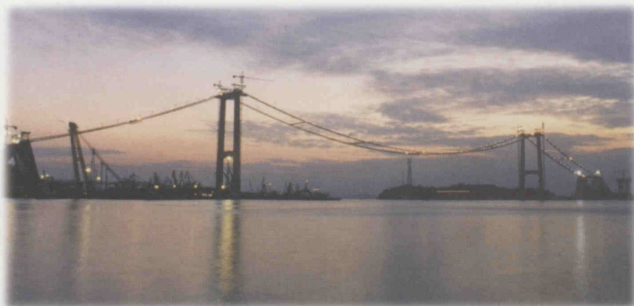
建设中的海沧大桥
