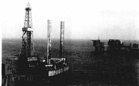
渤海湾海上石油井架
