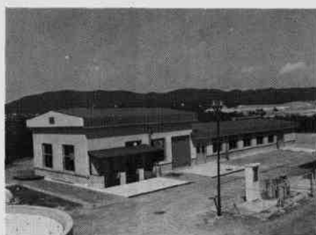
▲ 成形試験棟(窯業技術研究施設)
