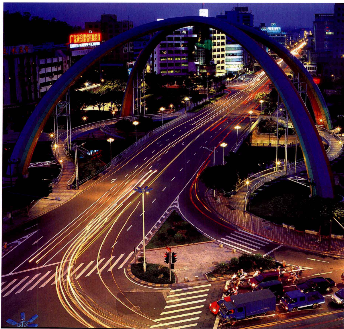
1987年7月凤山西路竣工通车 同年10月凤山桥正式竣工通车
