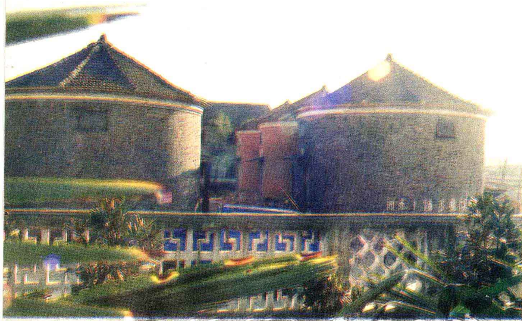
横溪乡粮管所1972年建造的砖园仓
