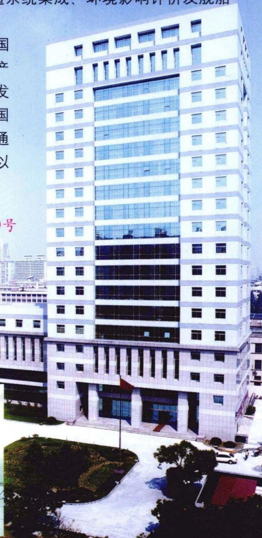
上海船研所总部大楼
