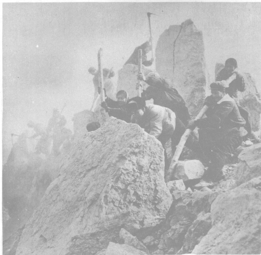
昔阳县城关公社钟村大队的民兵突击队在劈土造地。
