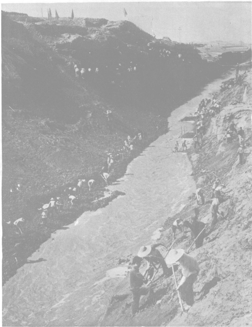
昔阳县南河改道、造地。
