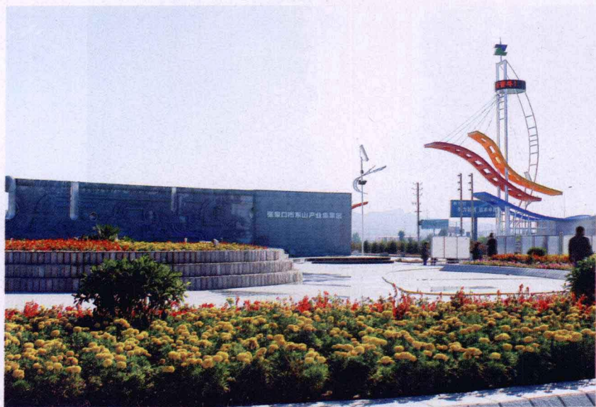
建设中的东山产业集聚区
