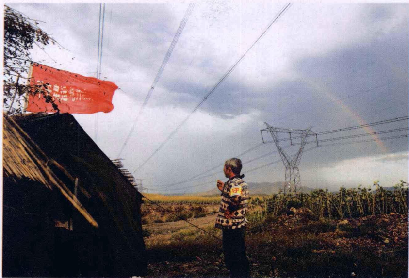
奥运安保期间志愿者在野外守护电塔
