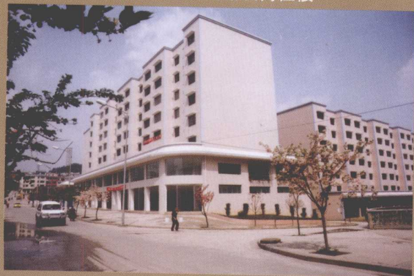
开阳县开州大道紫江花园商住楼
