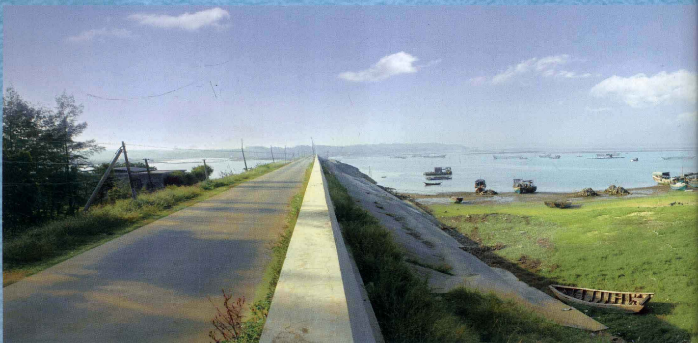
井仔防护海堤、硬底化水泥路
