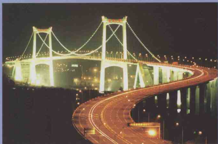
■ 厦门海沧大桥
