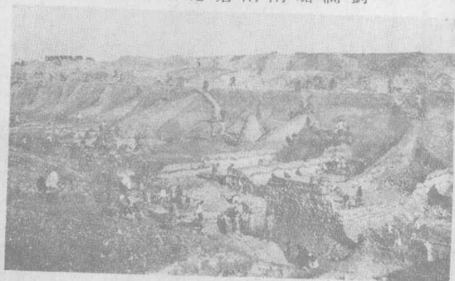
劉澗船閘閘塘挖土工程
