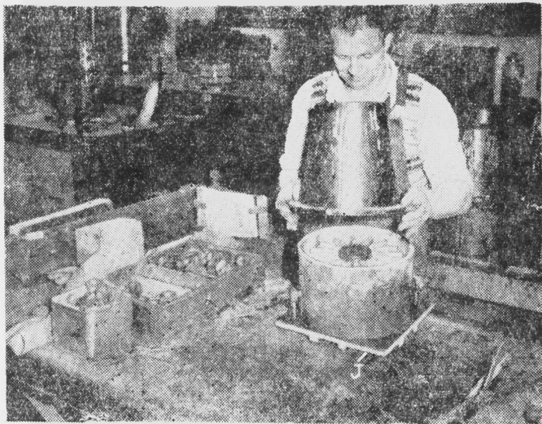
圖5. 將組合好的蠟模放在鋁板上，並套上適當的砂箱準備倒入泥漿。
