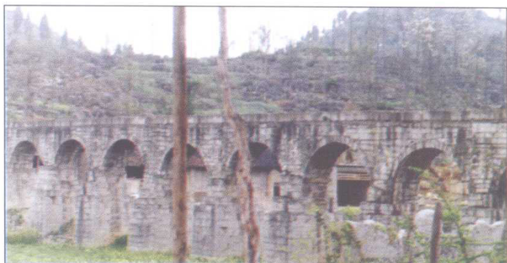
50年代建源村渡槽 ▷
