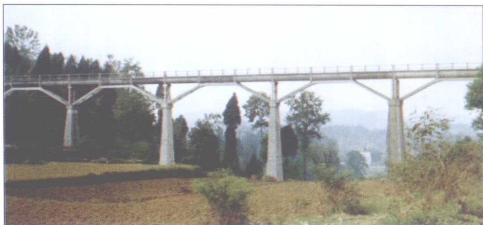
◁ 90年代建 磨子台渡槽
