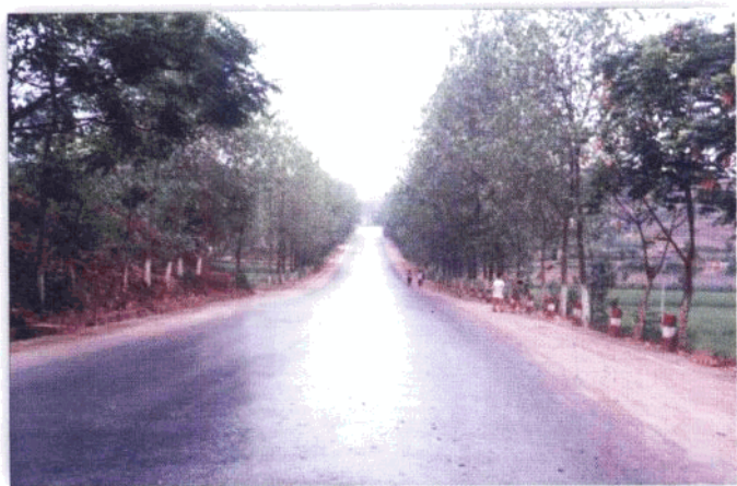
改造后的乡镇公路
