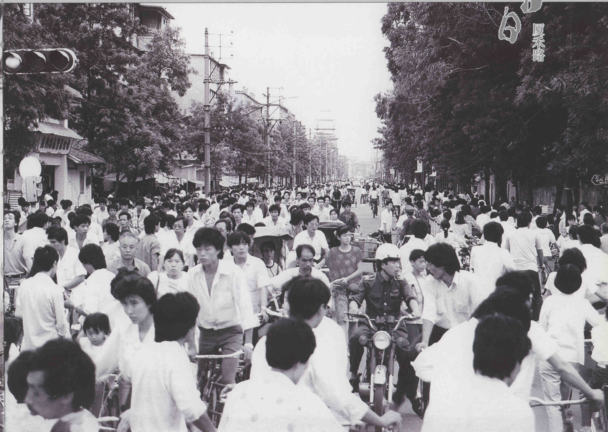
改造前，厦禾路人潮、车潮拥挤不堪
