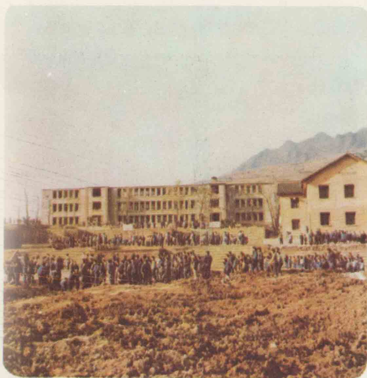
发展中的彝良县第一中学新建大楼
