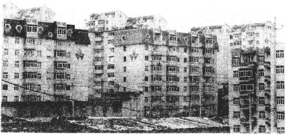
上海住宅建设
