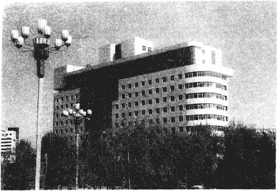
本钢总院新建楼
