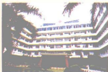
医院住院大楼
