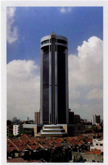
位于上海市区中心老锦江饭店东侧,是一座五星级宾馆。基地面积6800平方米,总建筑面积57300平方米,主楼地上43层,地下1层,总高153米。塔楼顶部设旋转餐厅。建筑造型以圆形轮廓与竖向线条结合,多角形塔身玻璃幕墙与铝板幕墙结合形成了建筑独特的风格。上海建筑设计研究院与香港王董国际有限公司联合设计,1990年建成。
