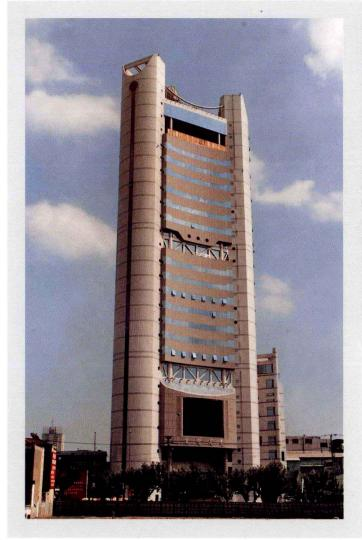
座落于南京西路繁华商业街上, 主要为广播电视技术业务和国际新闻交流会议, 办公用房等。 1994年建成, 高128米, 26层, 总建筑面积 30000平方米。建筑设计以城市环境与功能要求为出发点, 以室内大空间构想来适应广播电视技术迅速发展的需要。主楼采用角筒大跨度预应力梁的新型结构体系, 赋于建筑以个性鲜明的外部形象和灵活多变的室内空间。本工程获上海市优秀设计一等奖。本工程由华东建筑设计研究院设计。
