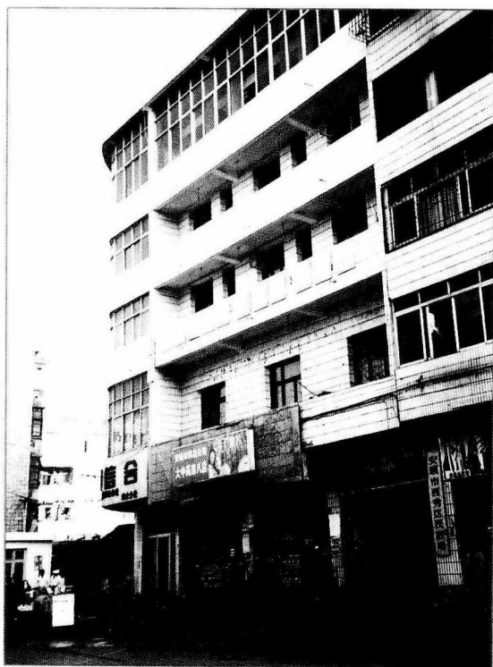
△ 安顺市西秀区民政局外楼（福利中心）建于1994年。
