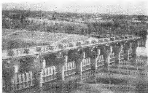
土门楼泄洪闸
