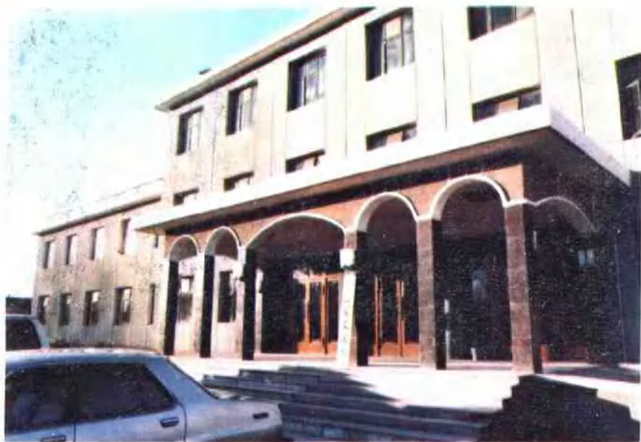
三河县交通局办公楼
