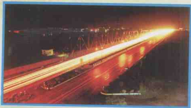
铁路、公路两用的大沙马房大桥
