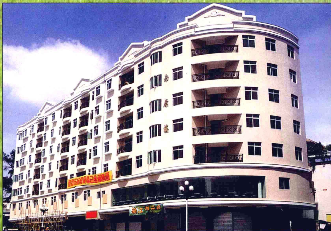
改造后的南环路南康楼
