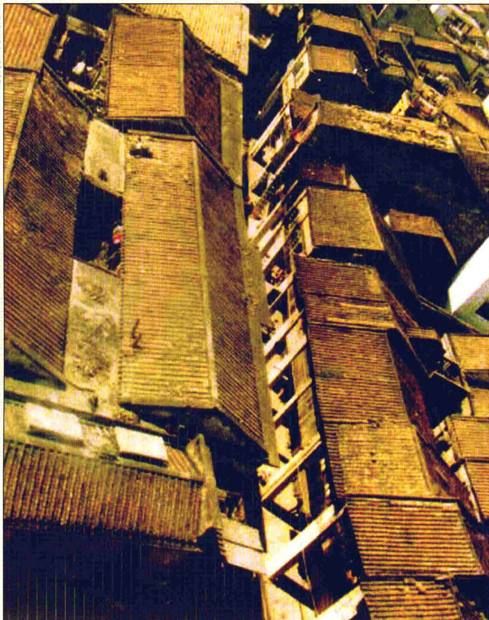
旧马路的原有建筑物
