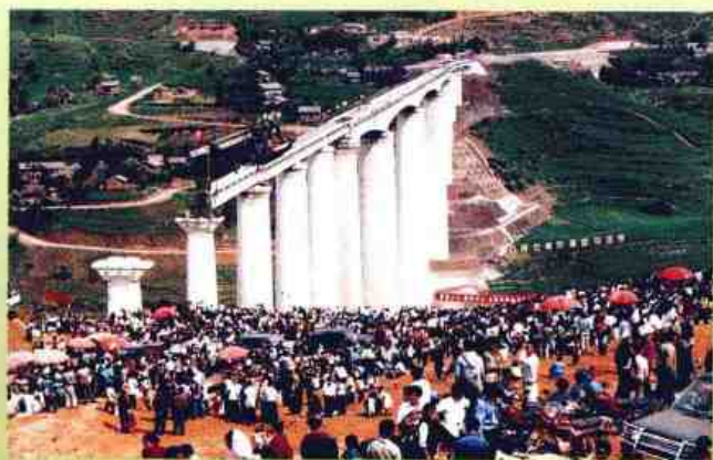
●2001年7月1日，内昆铁路南段铺架进入昭通境内的花土坡特大桥
