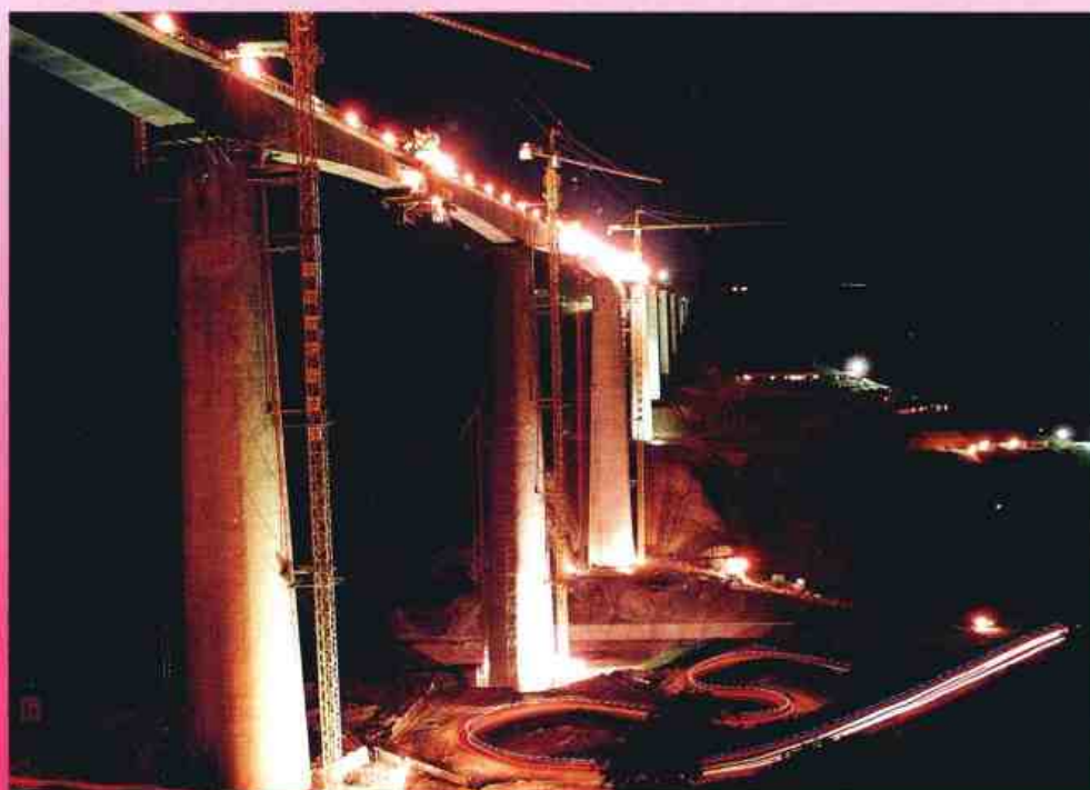
●黑夜中加紧施工的内昆铁路花土坡特大桥
