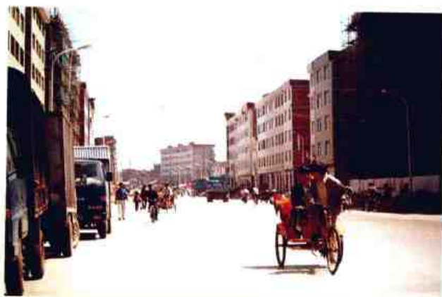
●2000年12月26日，昭通市重点工程之一的环东路竣工交付使用
