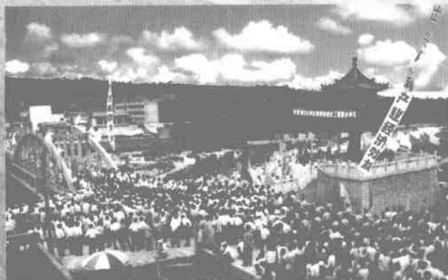
西安供水工程竣工通水庆典
