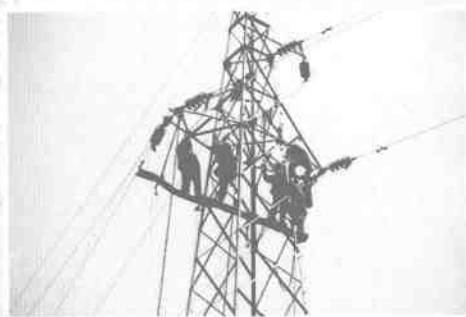
▲施工人员精心架设35kv线路
