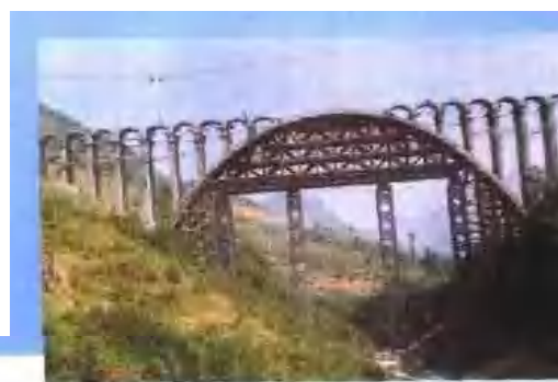
优良工程川甘公路(国道 212 线)干溪河大桥,桥长 132 米、高 60 米,施工一瞥。
