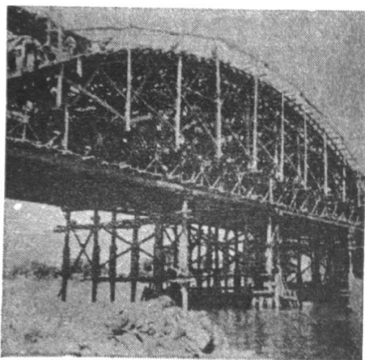
31. 贝雷钢桁与木拱盔结合的拱架（攸县铁路桥， L=40M ）。
