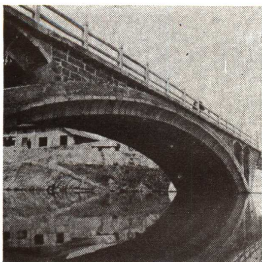
12. 石板滩桥。L = 35米， 主拱无肋无筋。
