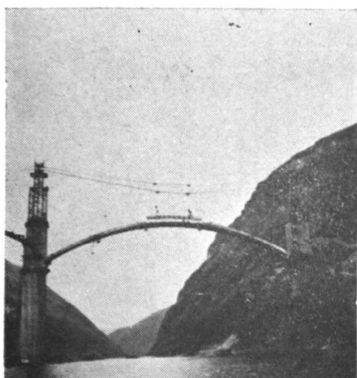
45. 五段吊的拱肋中段就位。
