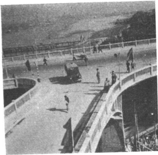
23. 正桥与支桥交汇处的 桥面结构（长沙大桥）。
