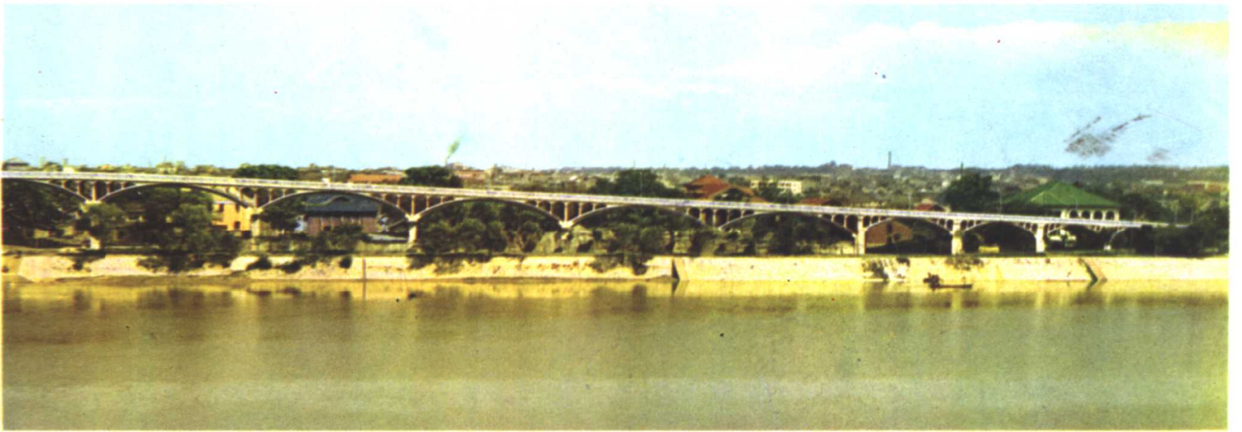
桔洲支桥全貌
