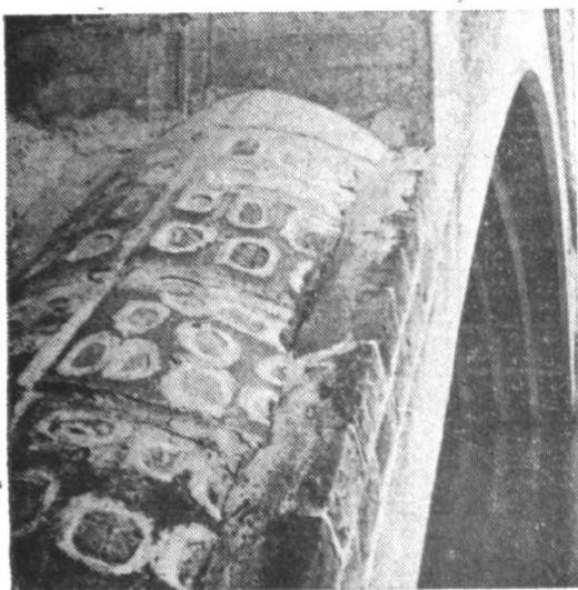
19. 双层卵石预制拱波，无拱版。(白竹水桥， L = 40 米)
