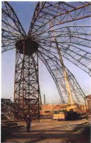
唐山启新水泥厂直径86.82米石灰石预均化库大跨度肋环穹顶钢结构吊装
