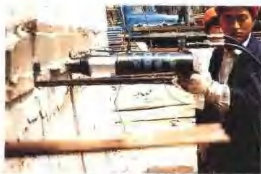
106米长无粘结预应力钢绞线张拉施工
