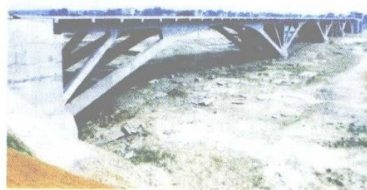
正在施工的以工代赈 工程——虎踞大桥
