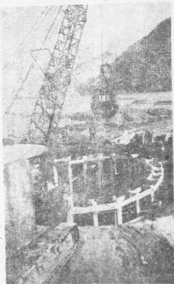
十墩明挖支撐施工
