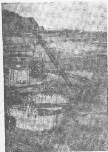
撈土機撈挖沉箱下沉情況
