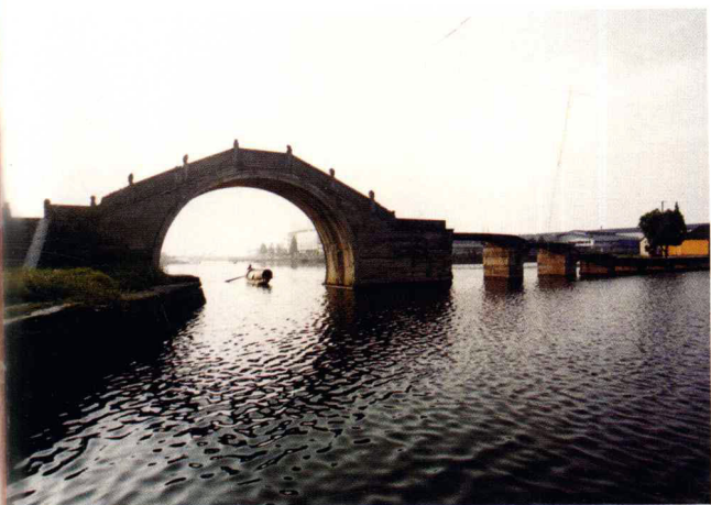
横跨古纤道的太平桥
