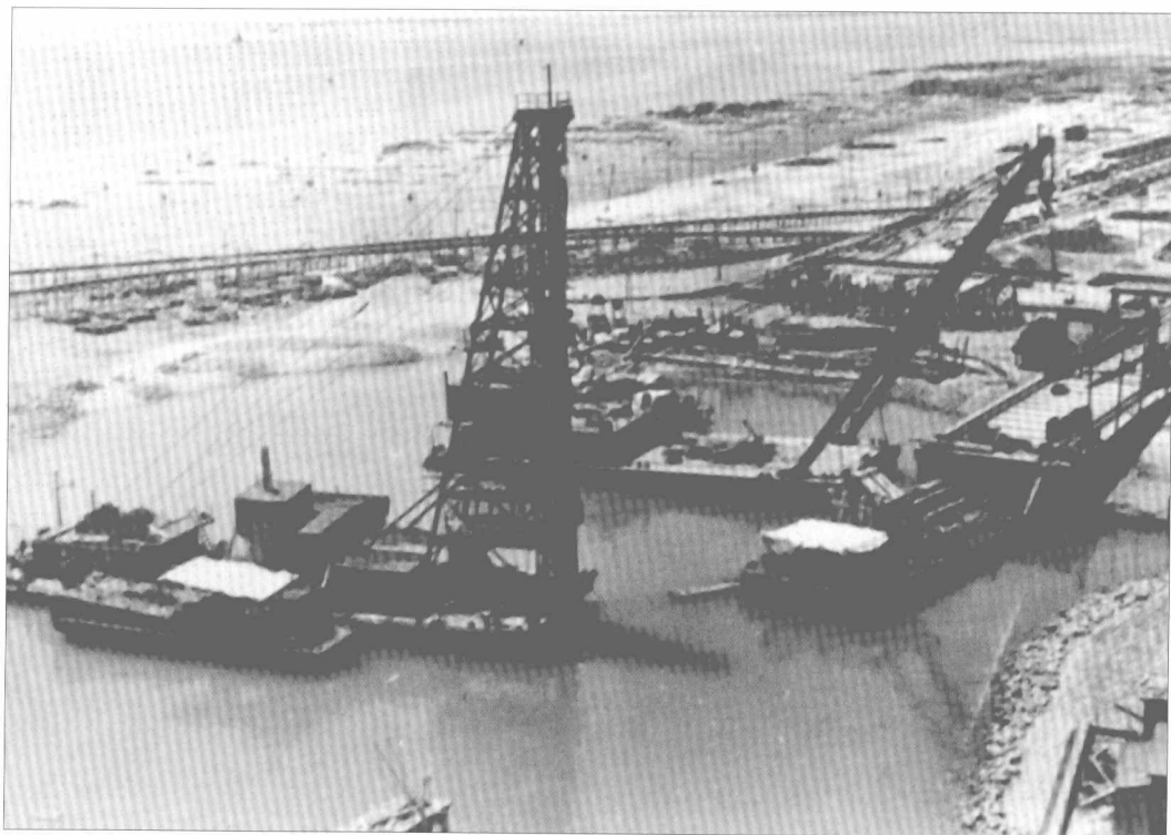
1956年5月1日，中国自行设计、施工的第一座现代化深水港——湛江港（第一作业区）提前竣工。图为湛江港建港工地。（湛江港务局提供）
