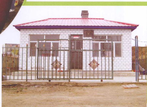
龙头村自来水泵站
