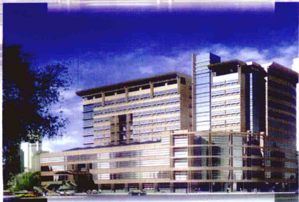
海淀医院新门诊大楼
