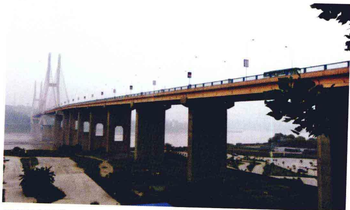
江南门户通道——李家沱长江大桥
