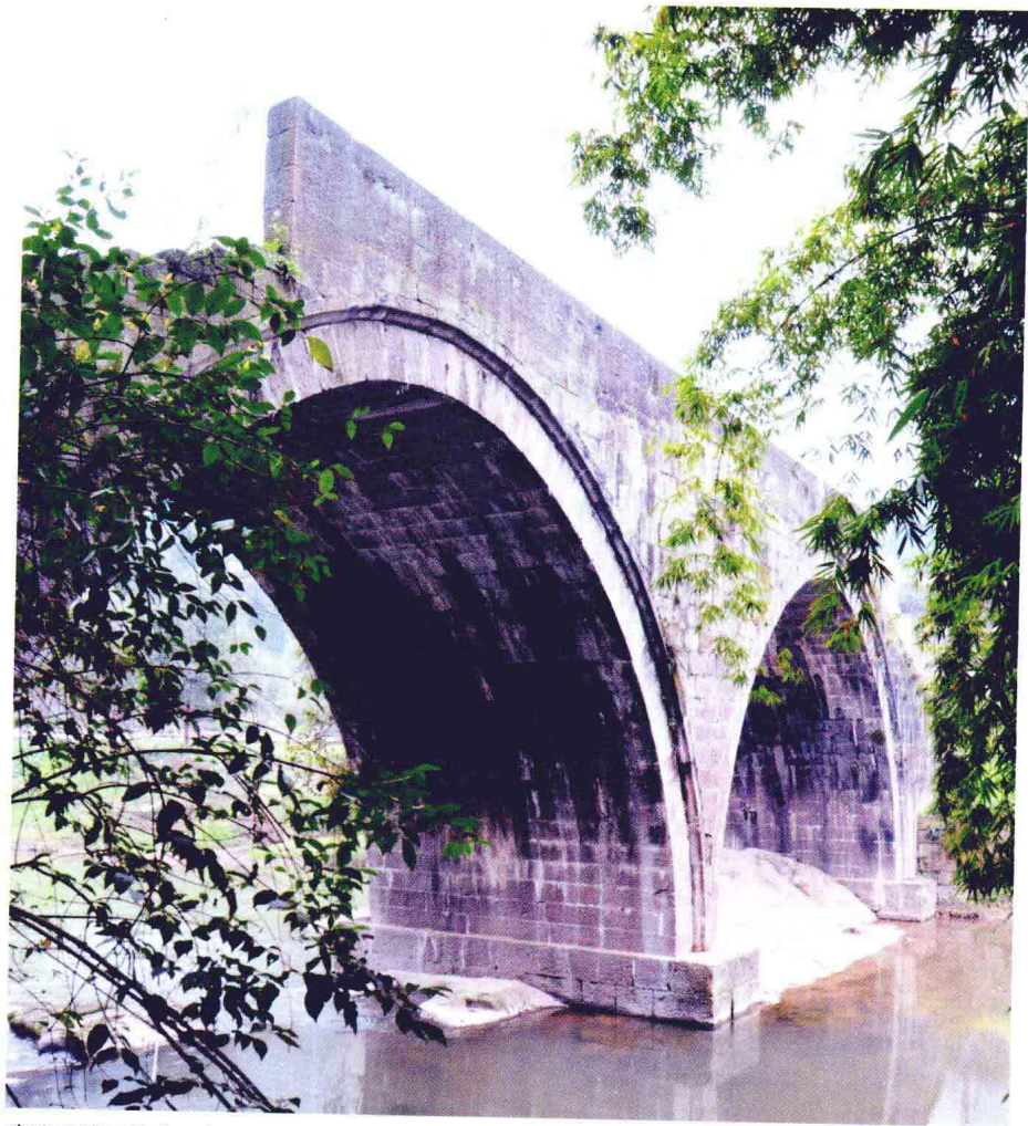
建造于清同治十三年（公元1875年）的双孔石拱桥——双星桥
