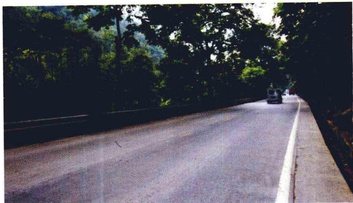
改造后的210国道——桥口坝段
