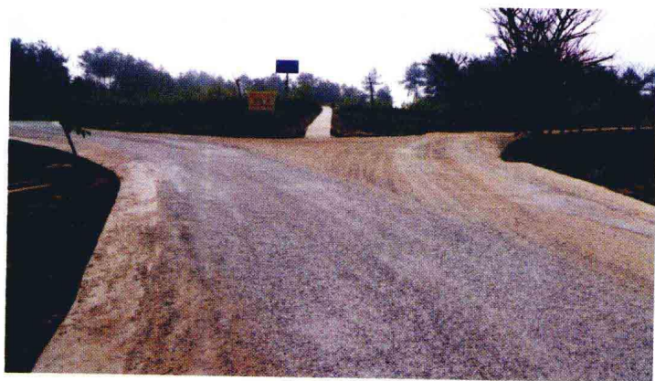
农村通畅工程样板路——碑（垭）二（圣）路集体村段
