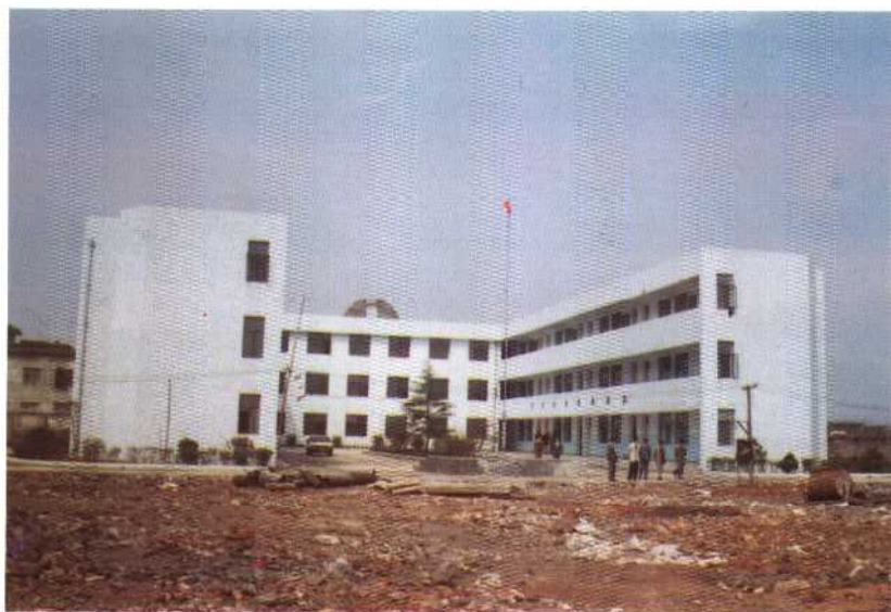
鄞县下应镇德培小学教学楼全景
