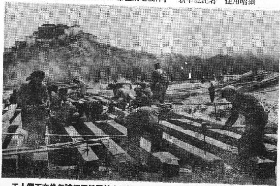
工人們正在修復被叛匪燒毀的布達拉宮后面的木橋。新華社記者 任用昭攝
