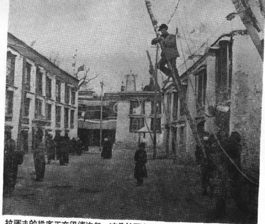
拉薩市的秩序正在迅速恢復。這是拉薩電廠工人在街上修復電綫。在叛亂中，叛匪曾瘋狂地砍斷了市區的電綫杆。 新華社記者 任用昭攝
