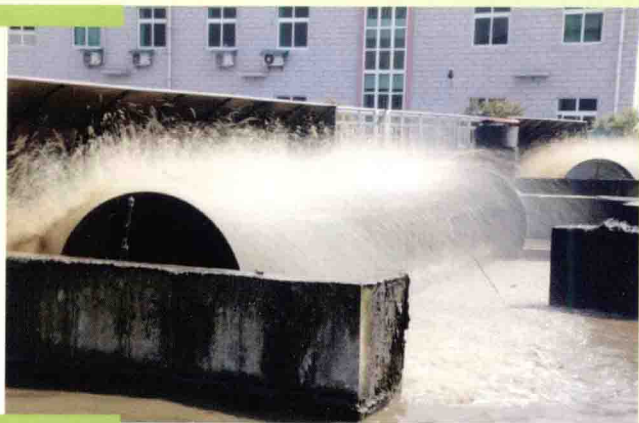
城市污水处理池之一
