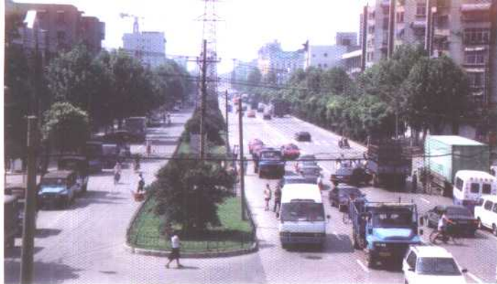
翻修扩建后的珞狮路
