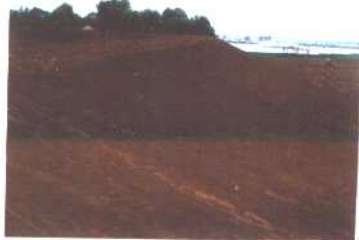
武惠堤土方加培工程
