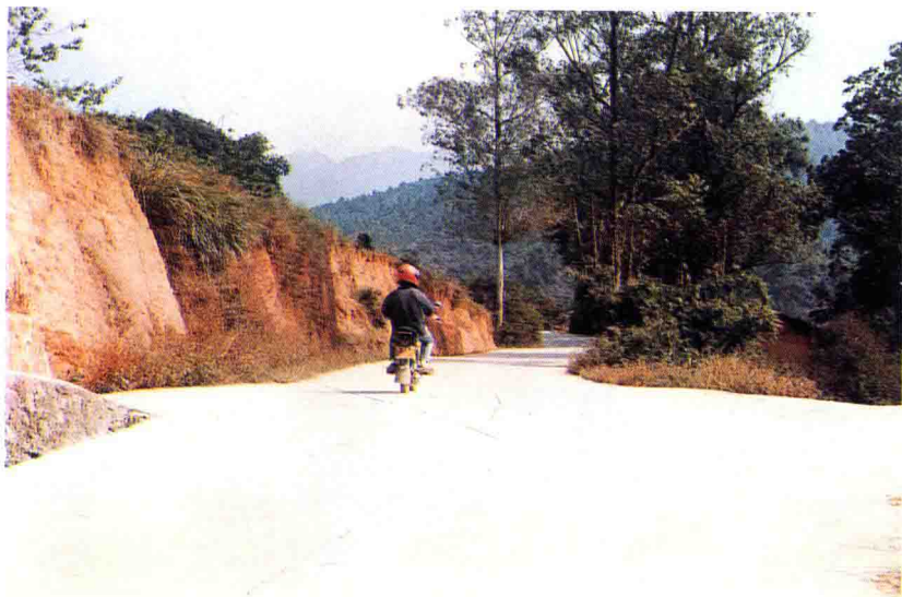
叶桂材先生捐资兴建的水泥公路——丙三公路赤石段
