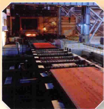
南京钢铁公司宽厚板厂炼钢连铸工程
