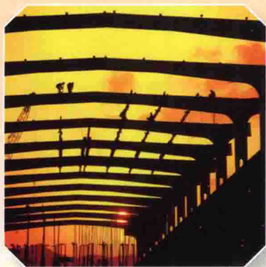
本钢连铸工程主厂房钢结构工程
