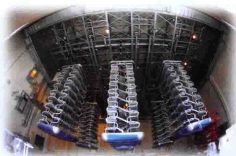
施工人员在换流阀上安装配件
