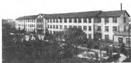
病 区 大 楼 (一九六二年建成)
