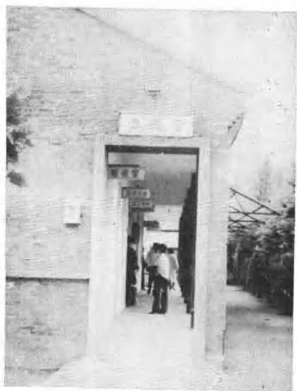
急诊室 (一九七八年建成)
