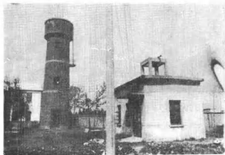
水泵房和水塔
