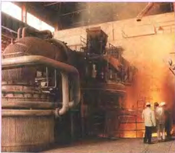
炼钢一厂 30 吨直浇炉
