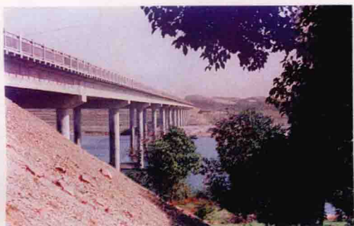
△分局工程队承建的 320 国道上饶境内最长的桥梁:潭石大桥
