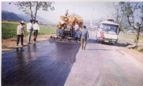
△沥青路面稀浆封层施工场景
