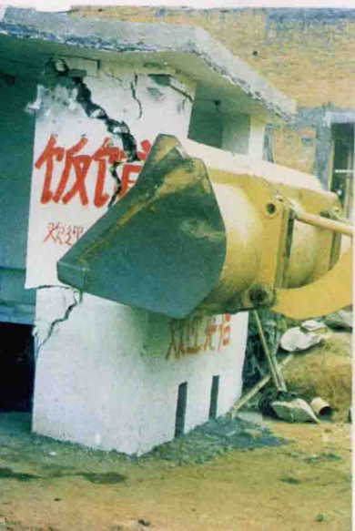
▽拆除公路旁的违章建筑
