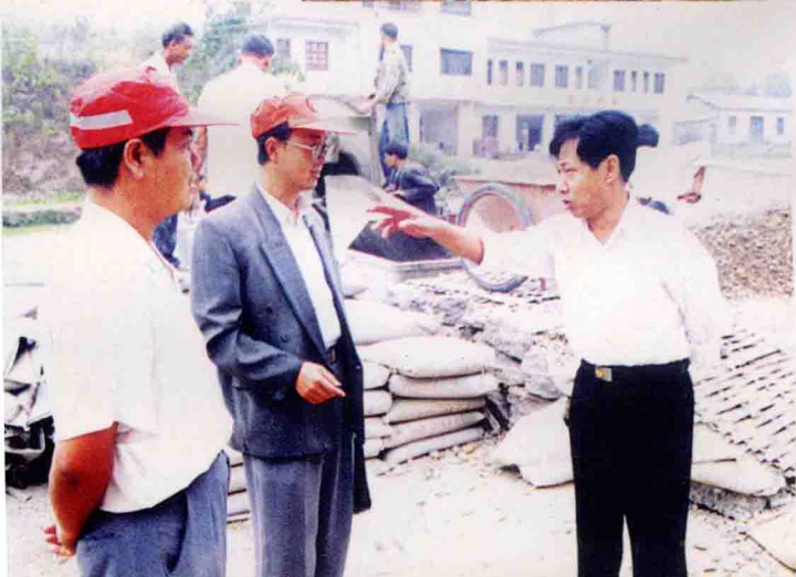
（右一）到道路施工现场 △分局党委书记李加恩
