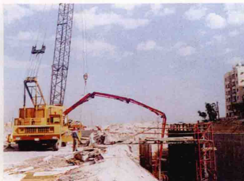
△援助科威特参加桥梁墩台施工场景
