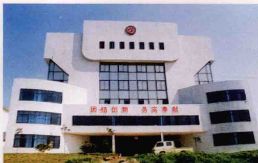
新建的办公楼 ◁ 广丰公路段
