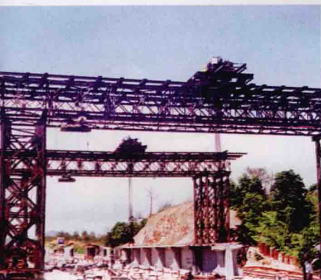
△桥梁预应力 T 梁预制吊装设施
