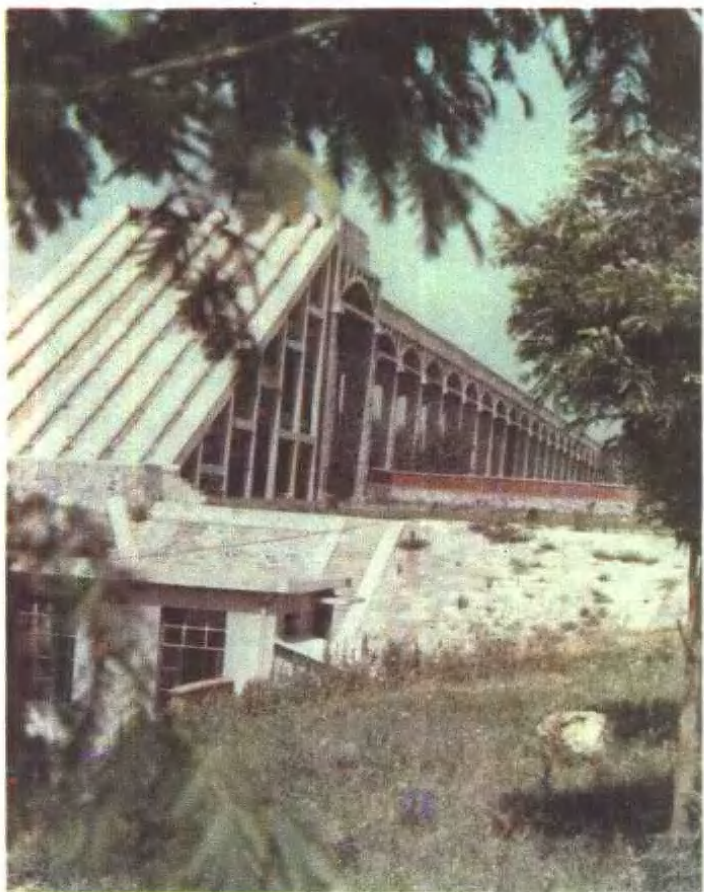
尖山翻水站渡槽
