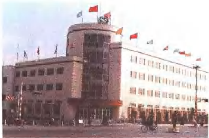
武清县邮电大楼
