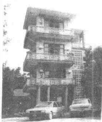
上犹县水电公司宿舍楼一角
