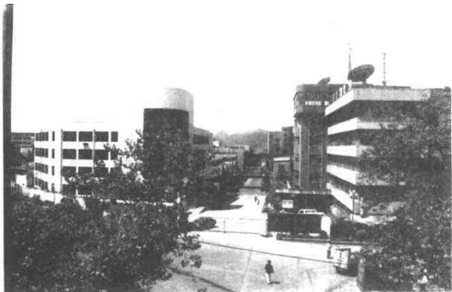
贵州轮胎股份有限公司办公、科技大楼
